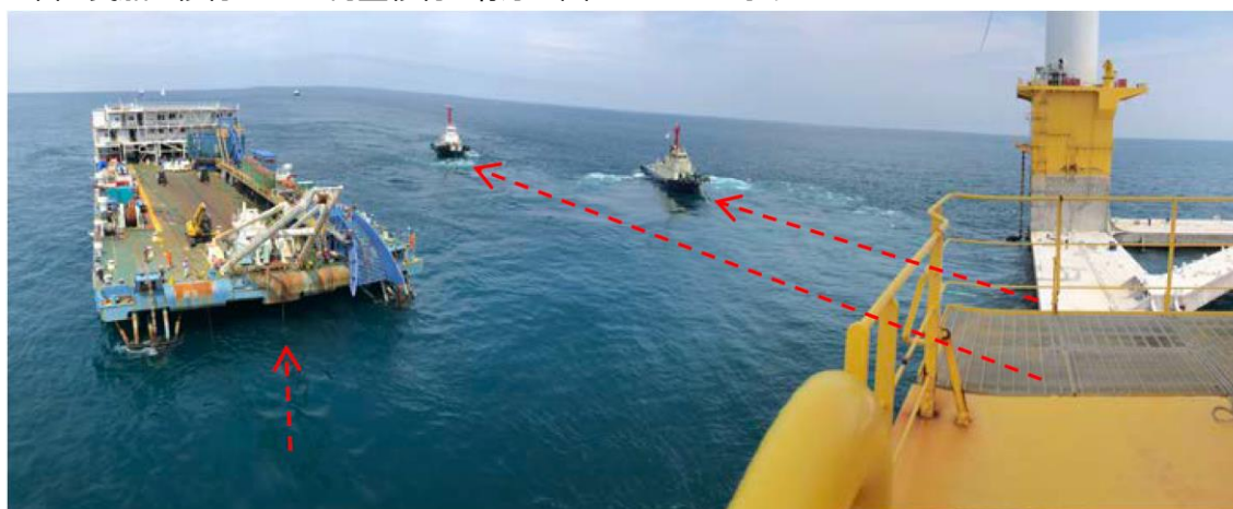
図 2.8-20 台船ウインチ及び曳船による風車浮体の引っ張り
