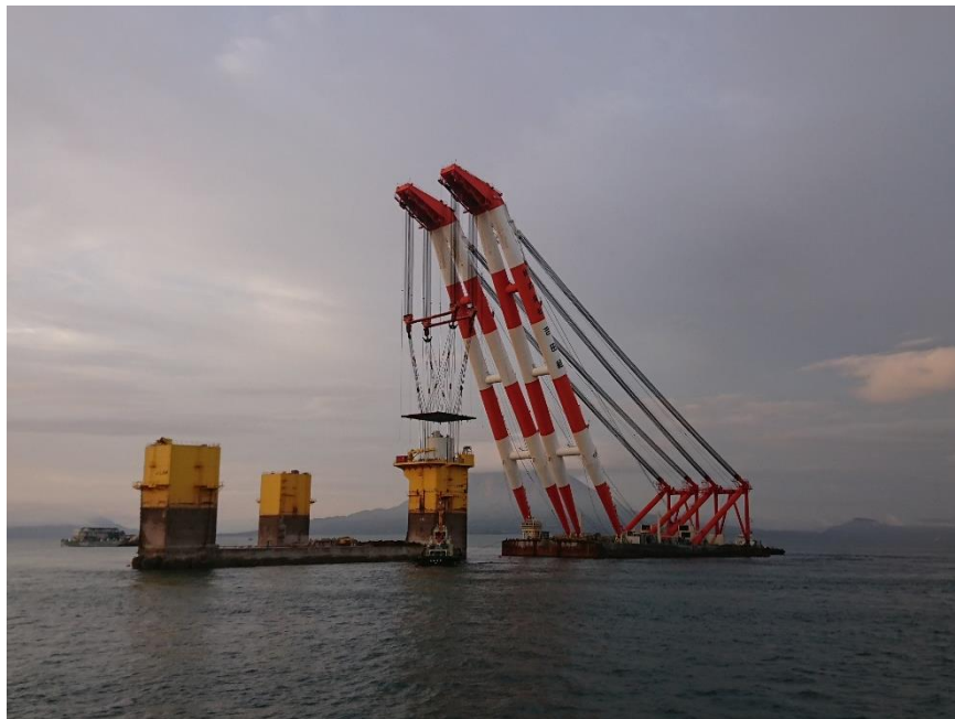
図 2.8-33 センターコラムの吊上げ
