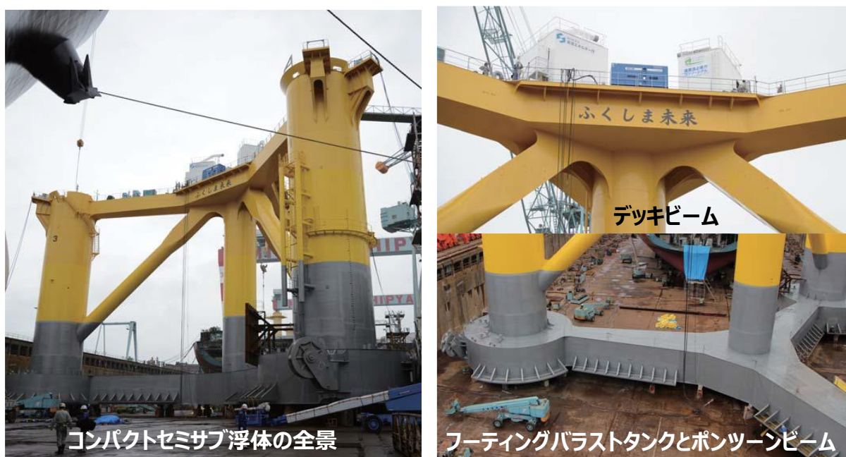
図 2.6-8 2MW 浮体の建造
