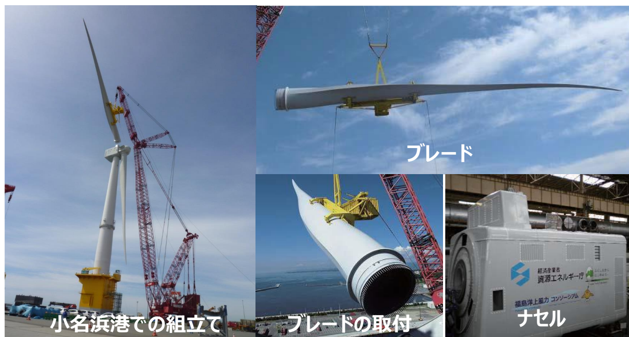
図 2.6-30 小名浜港湾における 7MW 風力発電設備の組立て
