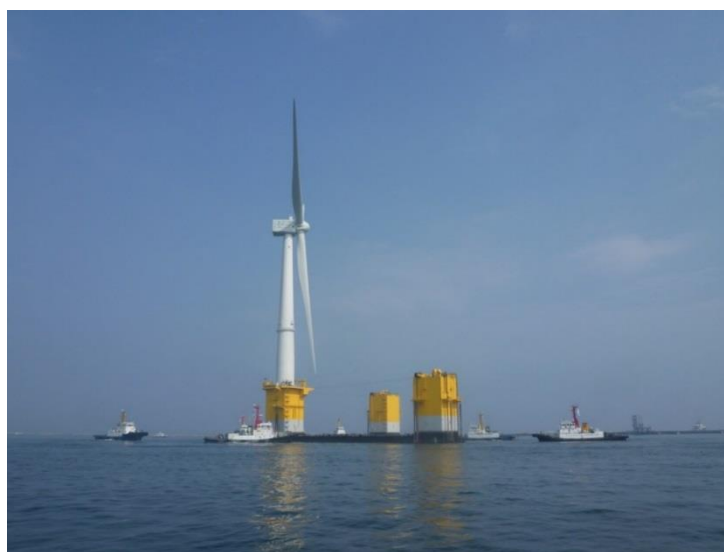
図 2.6-31 7MW 浮体の曳航（小名浜港～実証海域）
