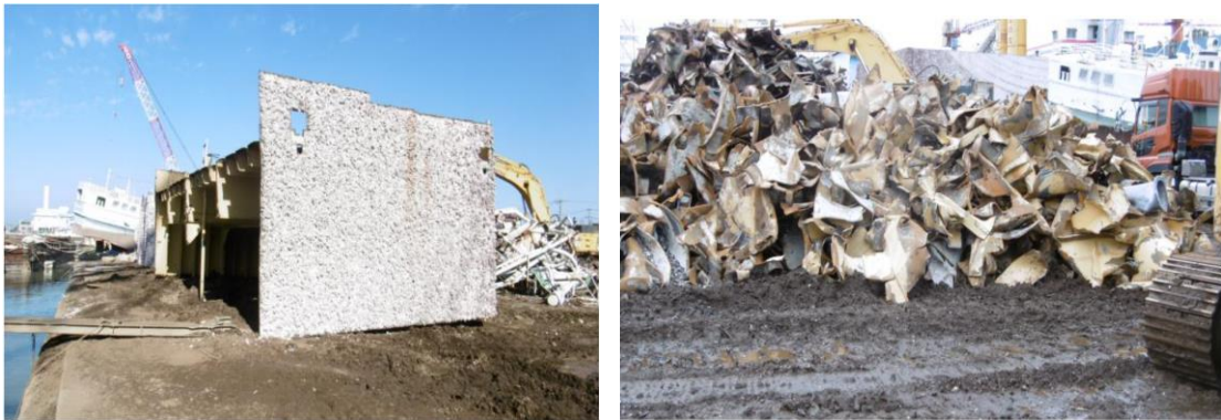
図 2.8-36 陸揚げされたコラムと切断後の浮体
