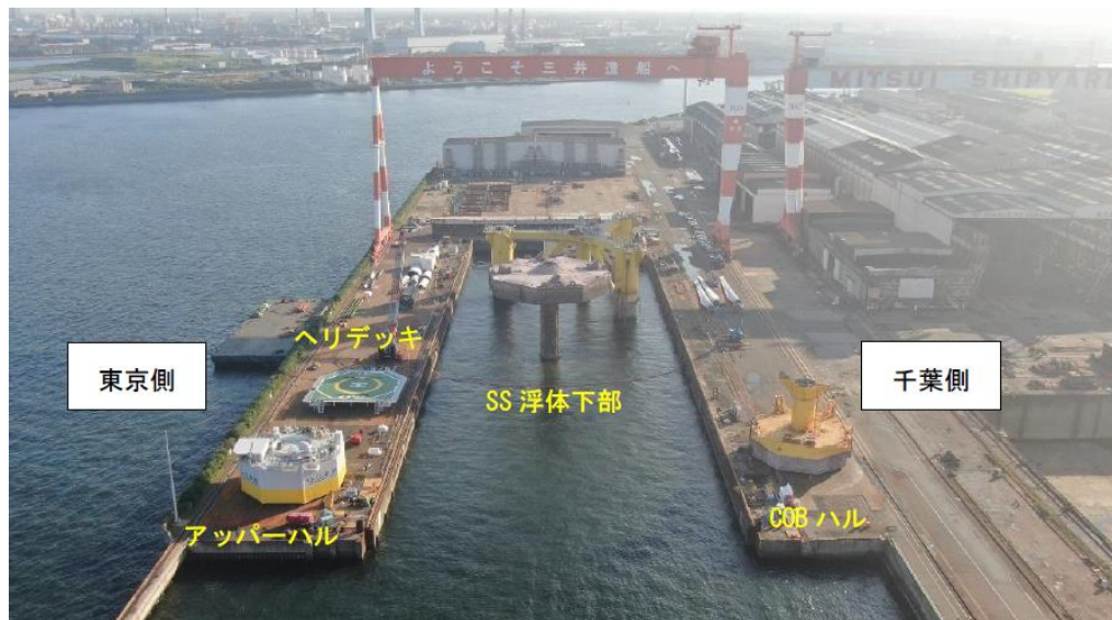
図 2.8-46 浮体上部分割仮置完了後の様子
