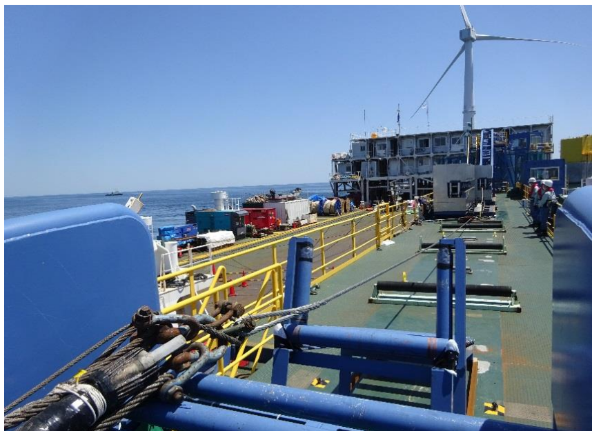
図 2.8-16 ケーブル敷設装置への取り込み
