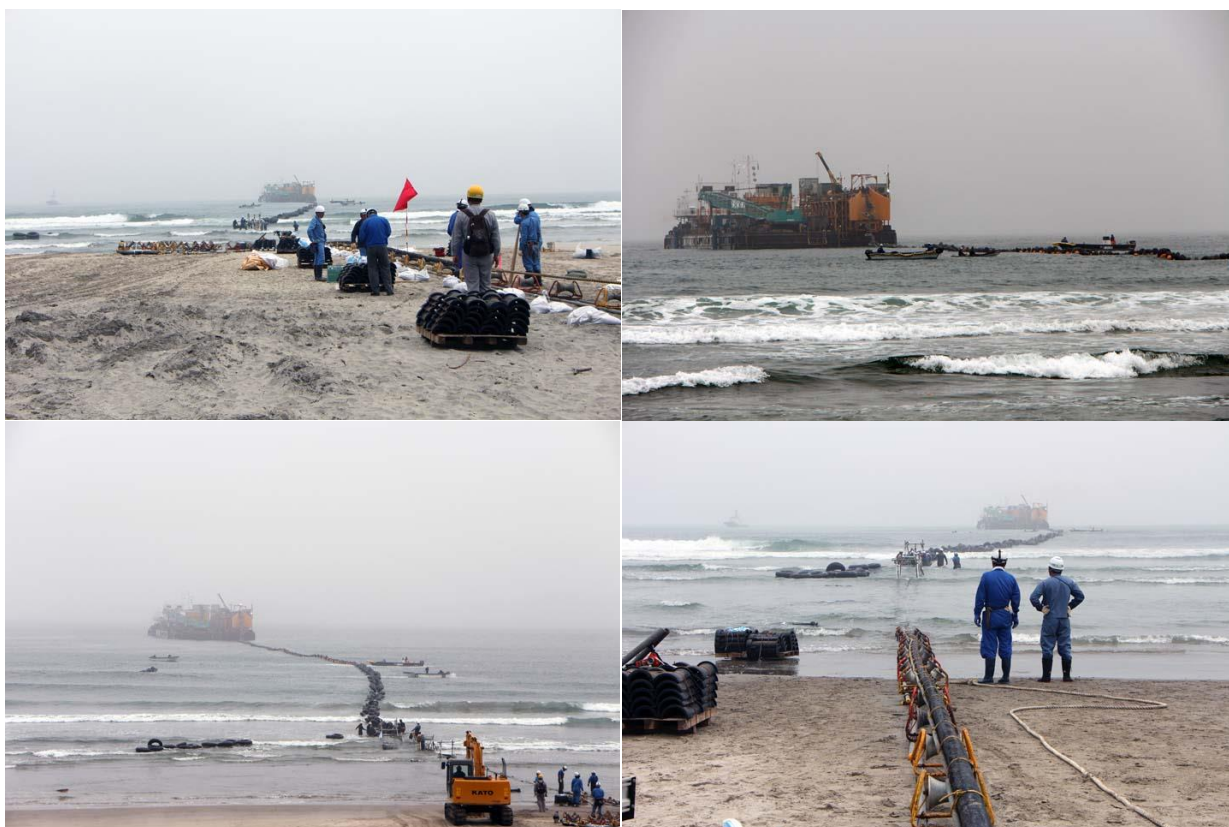
図 2.6-17 海底ケーブルの敷設の様子
