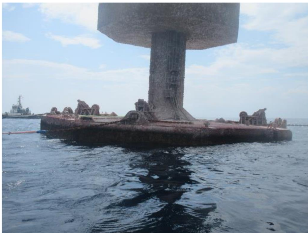
図 2.8-38 バラスト調整によるサブステーション浮体傾斜付け状況
