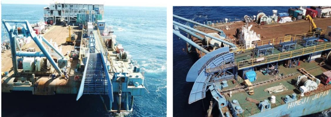
図 2.8-54 海底ケーブル回収の様子
