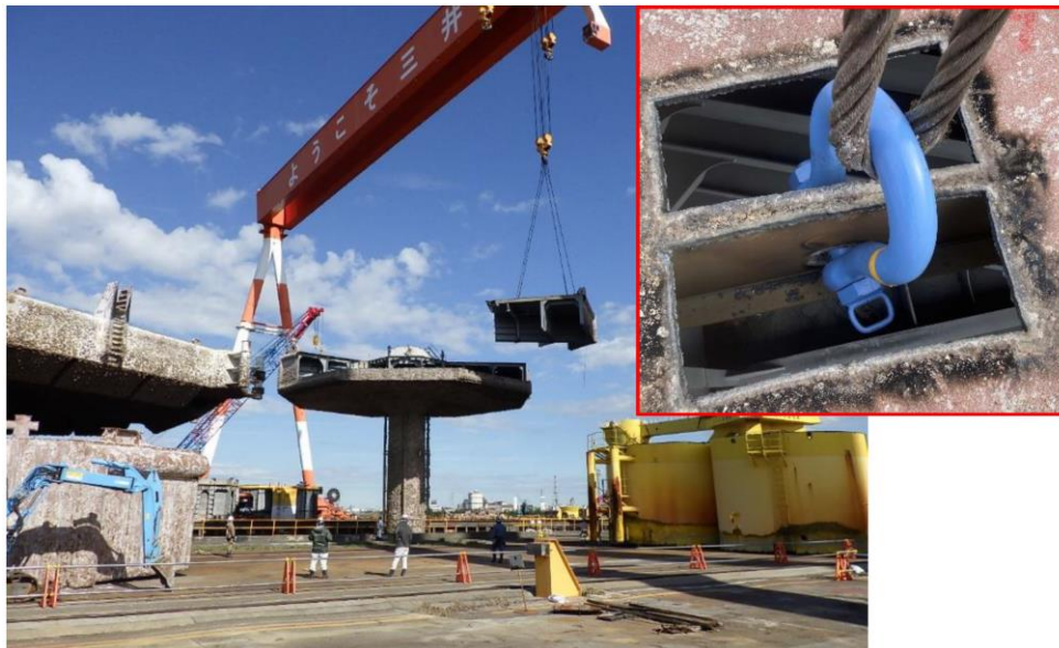
図 2.8-48 ミドルハル撤去の様子
