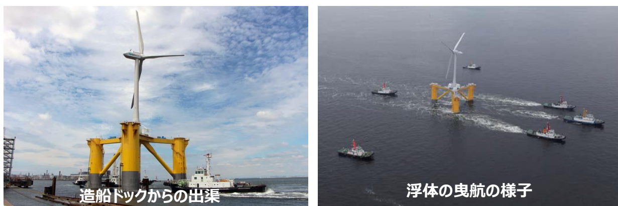
図 2.6-10 2MW 風力発電設備・浮体の曳航（東京湾市原～小名浜港）
