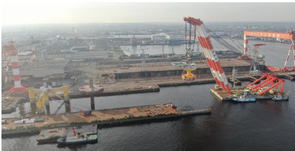
図 2.8-45 サブステーション浮体上部一括撤去の様子
