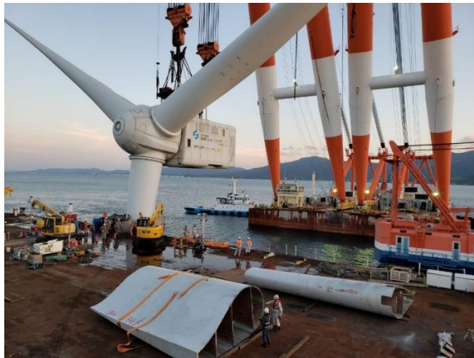
図 2.8-32 ブレード切断作業
