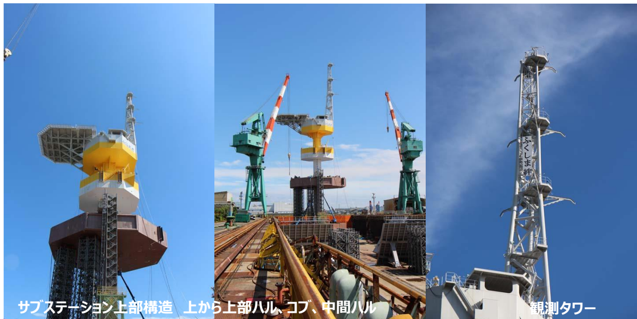
図 2.6-19 サブステーションの全景と観測タワー
