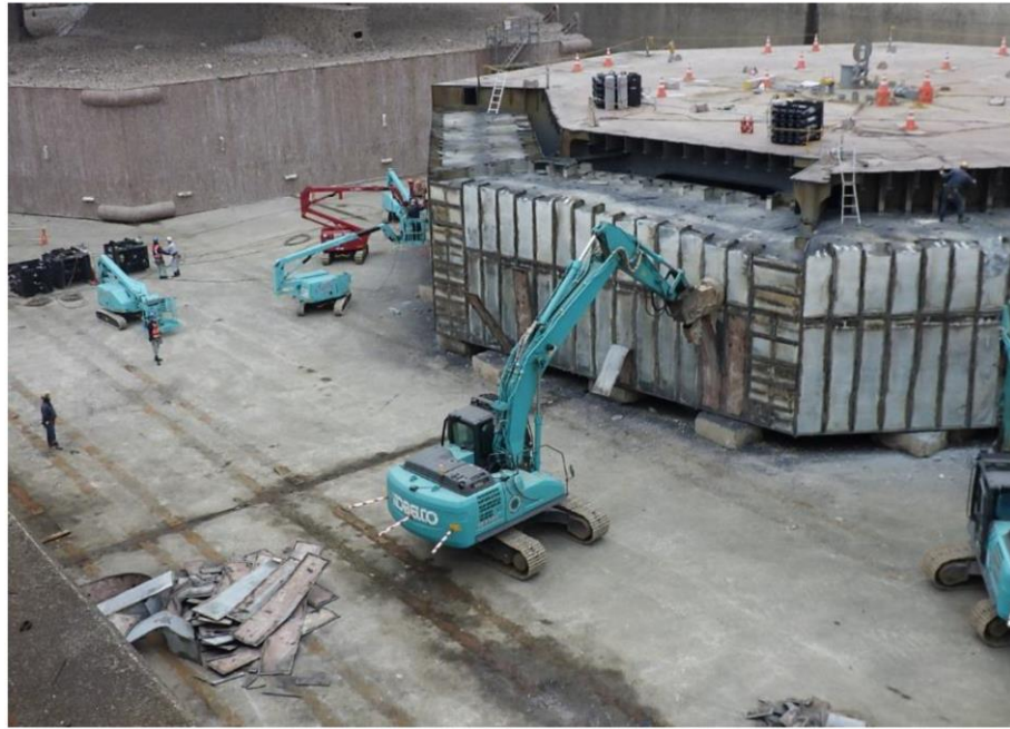
図 2.8-50 ローハル外板撤去の様子
