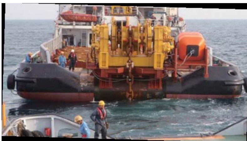
図 2.6-14 係留チェーンの敷設作業
