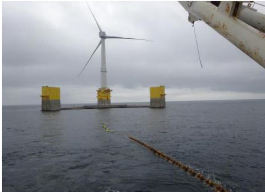
図 2.8-15 風車浮体側ケーブルの海中仮置きの様子
