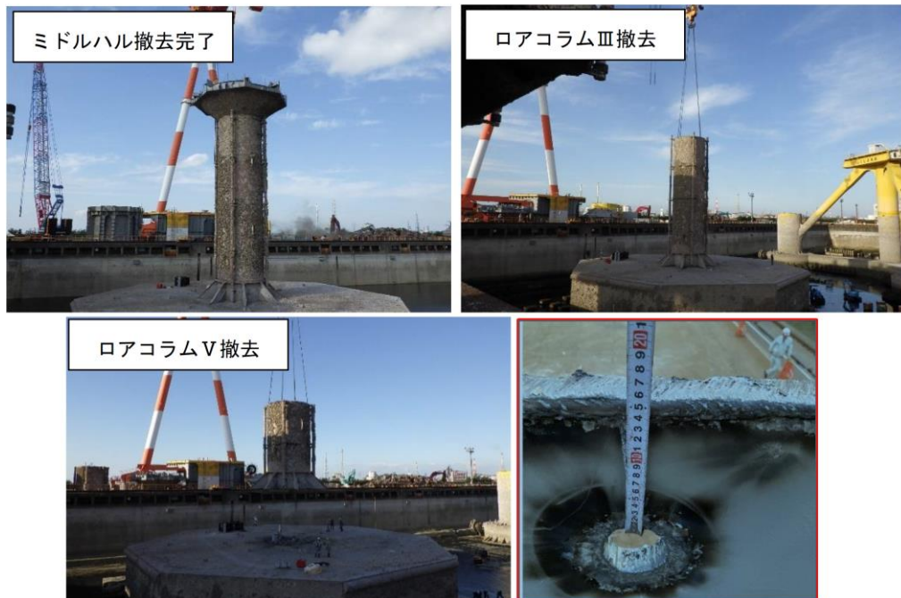
図 2.8-49 ローコラム撤去の様子
