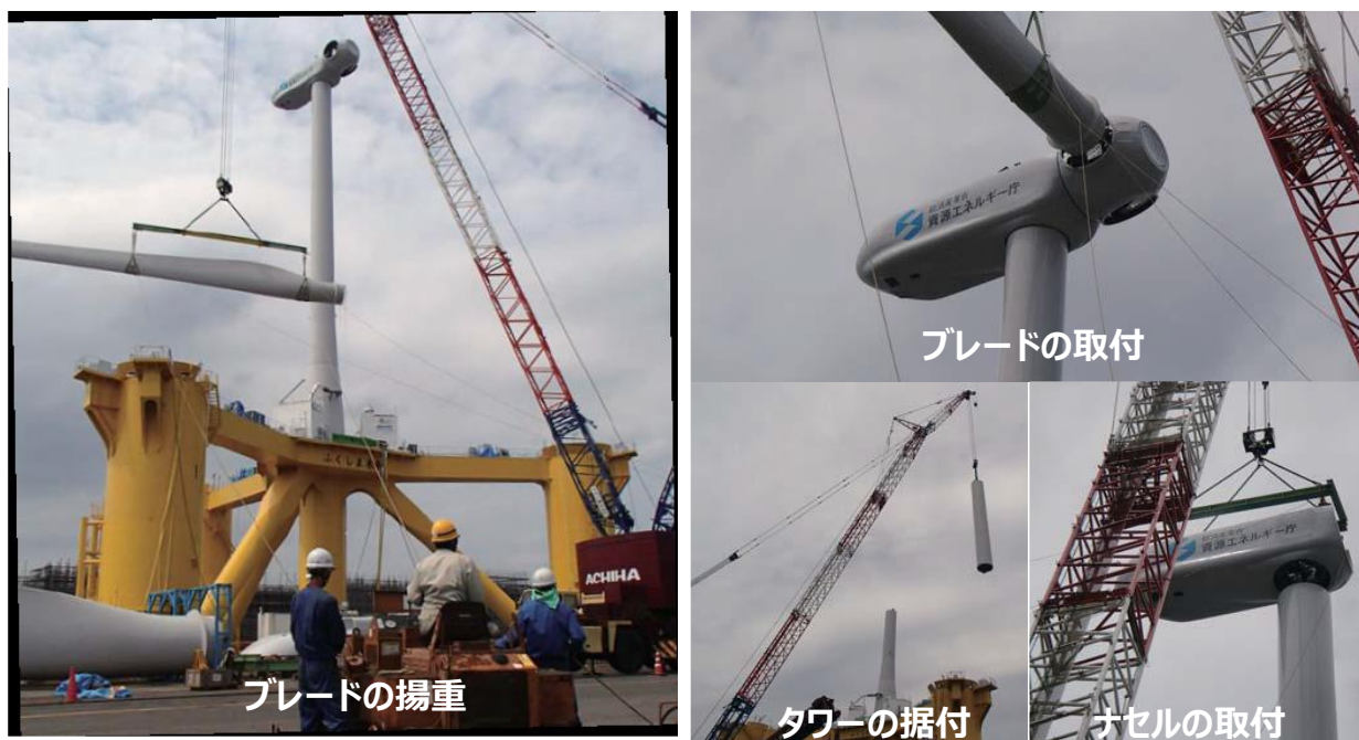
図 2.6-9 2MW 浮体における風力発電設備の建方
