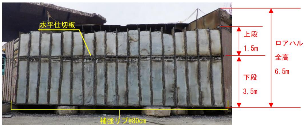
図 2.8-51 ローハル内のバラストコンクリート全景
