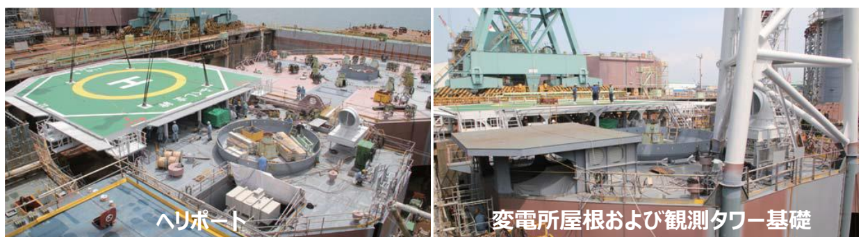
図 2.6-20 サブステーションの建設の様子
