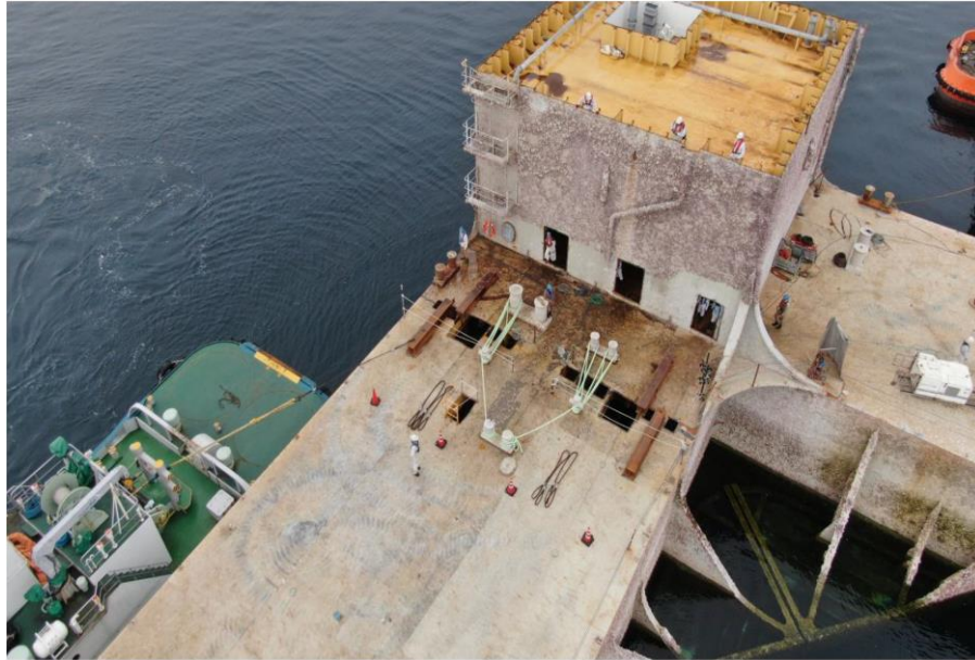
図 2.8-34 ワイヤソーによるローハル最終切断
