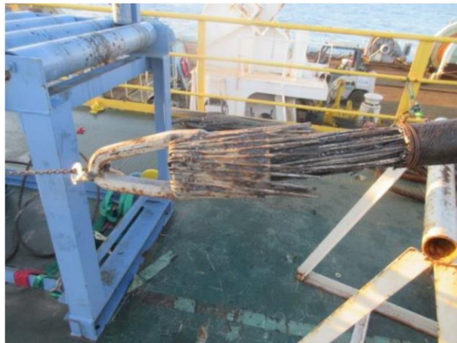
図 2.8-55 プーリングアイ取り付け後の海底ケーブル端部
