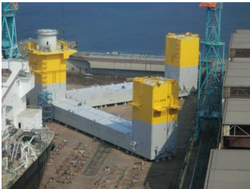
図 2.6-26 7MW 浮体の建造
