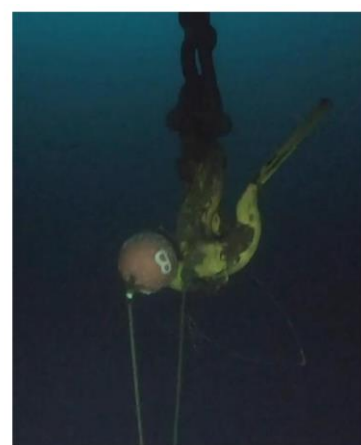
図 2.8-53 海底ケーブル端部引っ掛け時の ROV 画像
