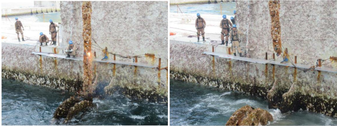
図 2.8-21 チェーン切断作業
