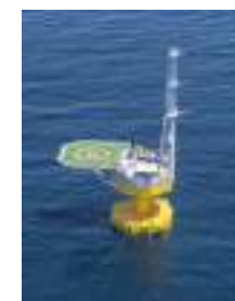
浮体式洋上変電所
