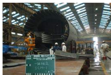
工場内浮体ブロック建造
