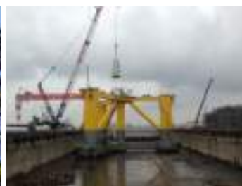
風車組立て(タワー)
