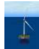
ふくしま浜風 5MW Advanced-Spar型
