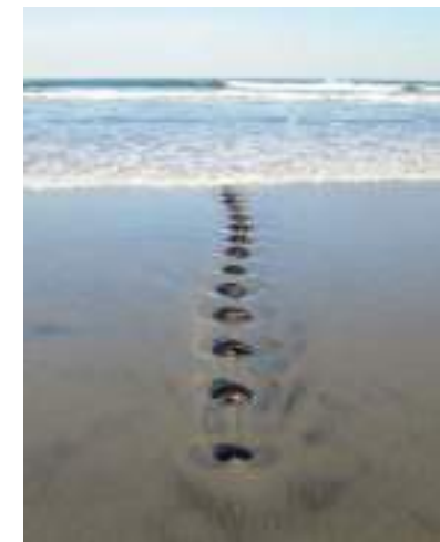
ケーブル露出の様子
