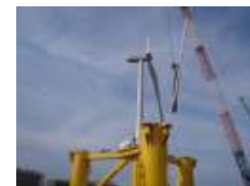
風車組立て(ブレード)
