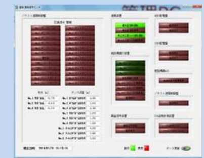
バラスト、航行安全設備稼働状況
