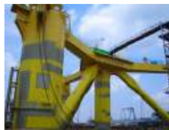
ドックにおける浮体建造
