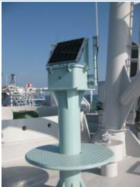
サブステーションに設置したAISアンテナ
