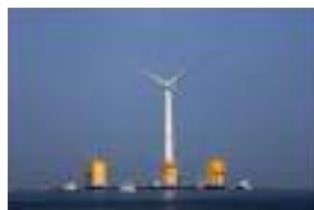
7MW風車曳航
