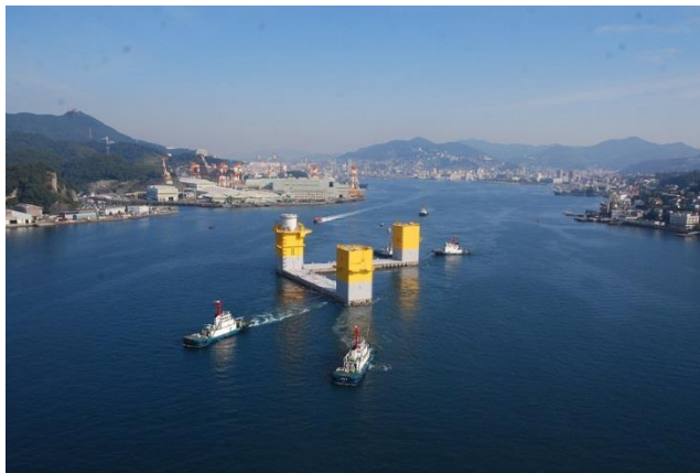
長崎港から出港した 7MW 級風車搭載用浮体
