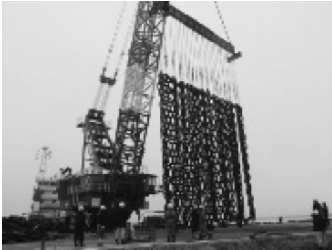
写真-1 吊り天秤を用いた敷設船への係留チェーン積み込状況
