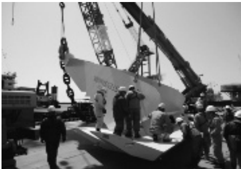
写真-2 係留アンカー
