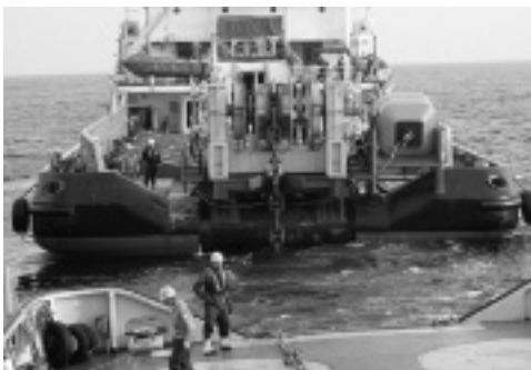
写真-3 係留アンカー・チェーン設置状況
