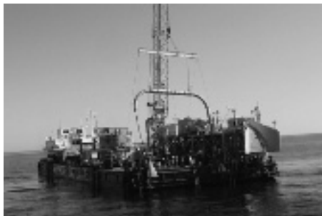
写真－8 ジョイントボックスの設置状況
