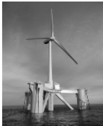
写真-7 設置完了後の2 MW級洋上風力発電船の状況
