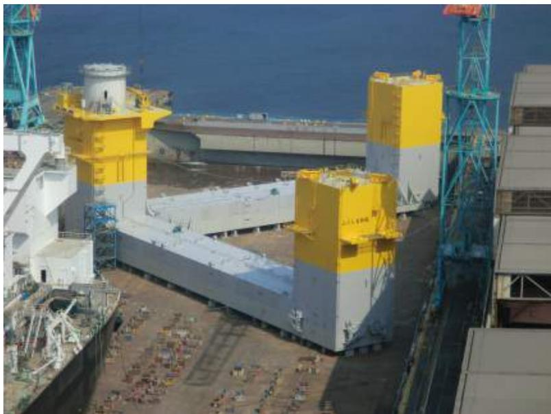
図 2.5-26 7MW 浮体の建造
