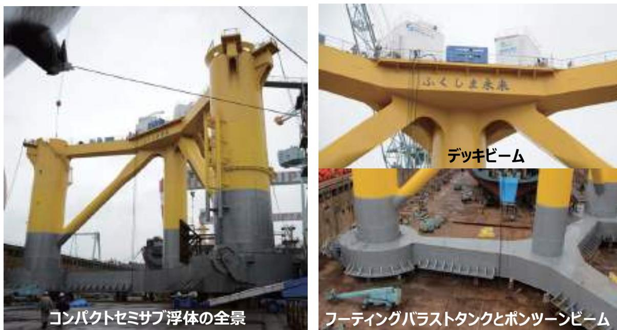
図 2.5-8 2MW 浮体の建造
