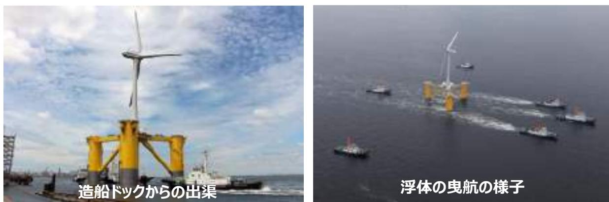
図 2.5-10 2MW 風力発電設備・浮体の曳航（東京湾市原～小名浜港）
