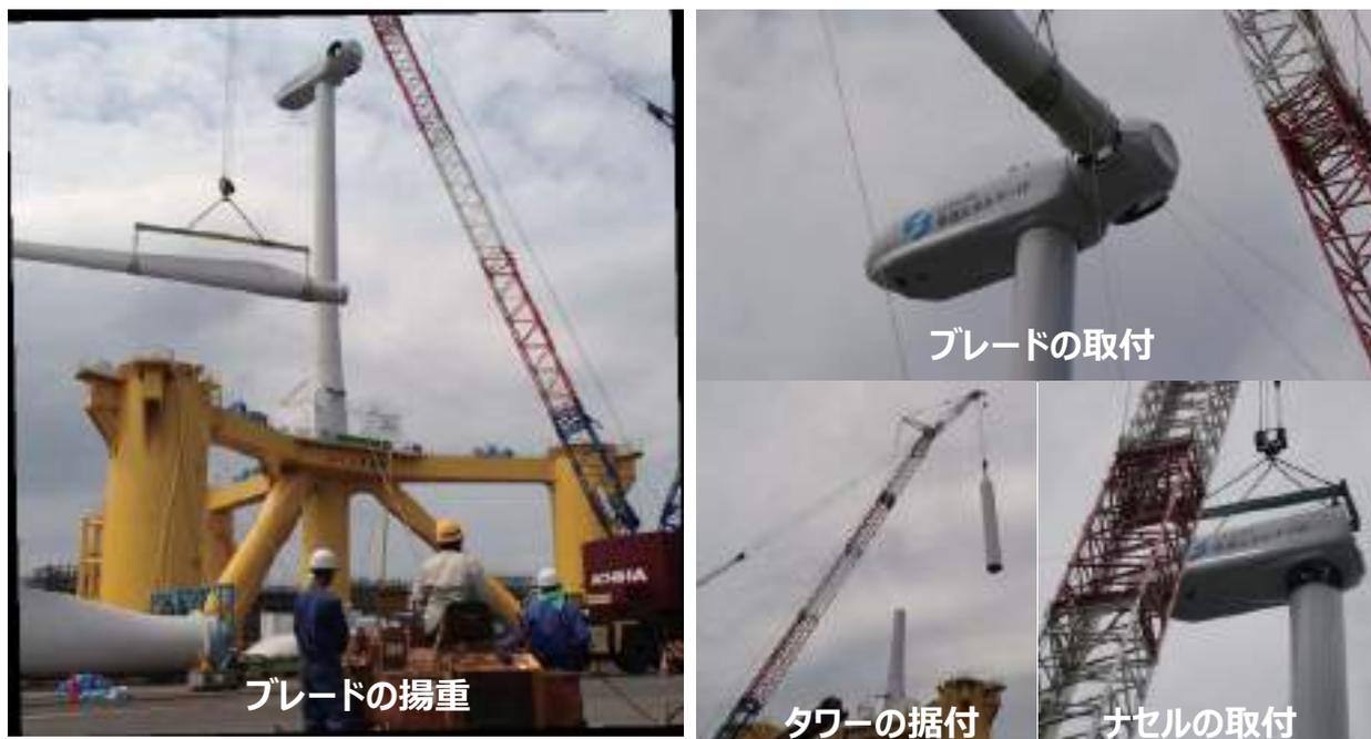
図 2.5-9 2MW 浮体における風力発電設備の建方
