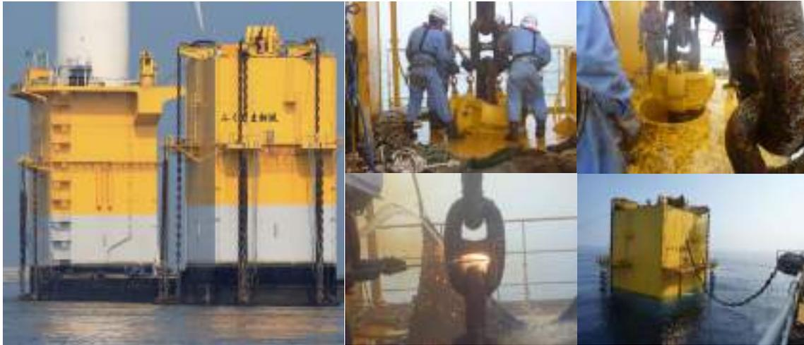
図 2.5-32 7MW 風力発電設備・浮体の係留
