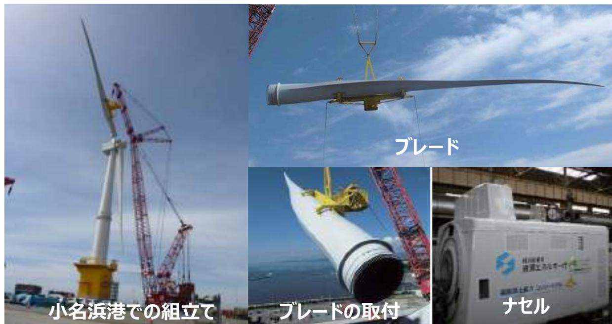
図 2.5-30 小名浜港湾における 7MW 風力発電設備の組立て
