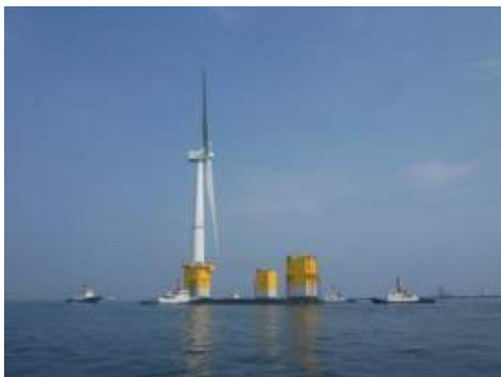
図 2.5-31 7MW 浮体の曳航（小名浜港～実証海域）
