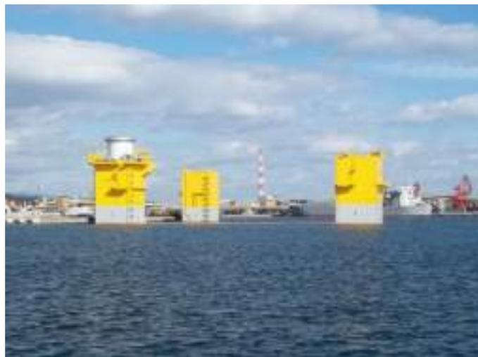
図 2.5-29 小名浜港における 7MW 浮体の着底
