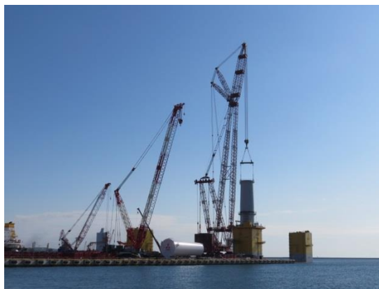
7MW 油圧ドライブ風車タワー組み立て（小名浜港）
