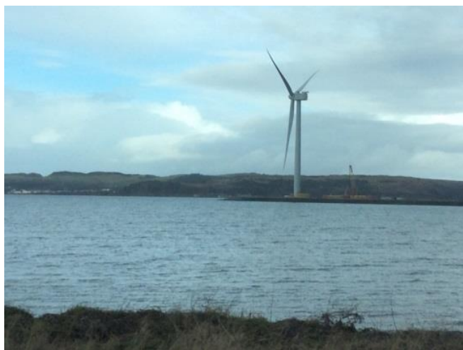
三菱重工製 7MW 油圧ドライブ風車陸上実証機（英国ハンターストーン）
