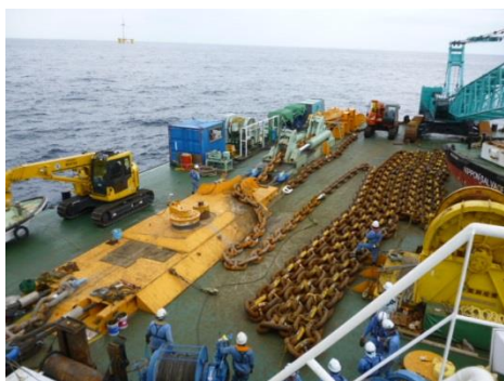
チェーン敷き並べ作業
