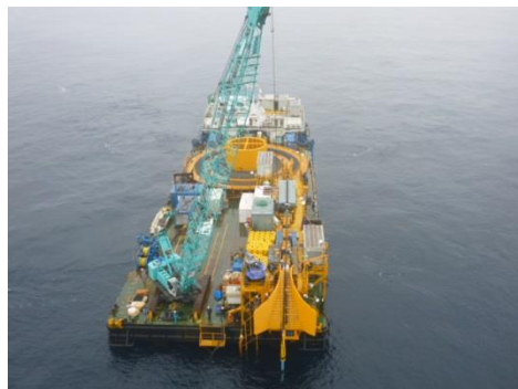
ケーブル敷設作業
