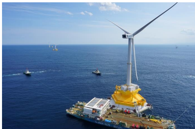
ふくしま浜風 係留作業の状況
